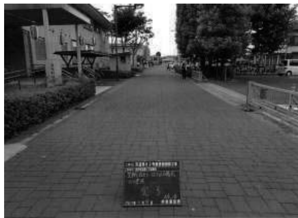
完了確認状況
