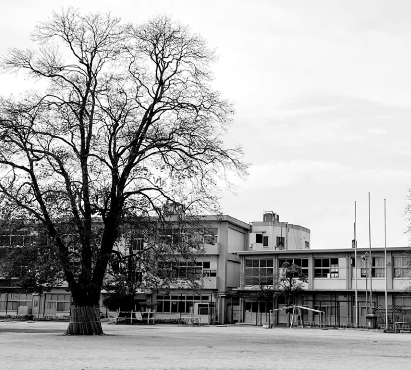
いよいよ7月から校舎の解体が始まります
