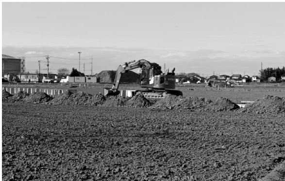
大型重機による水田の区画拡大の様子
