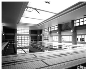
老朽化したプールの改修工事は7月から
