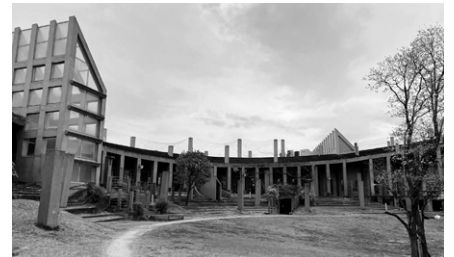
築46年の進修館の修繕は多岐にわたる
