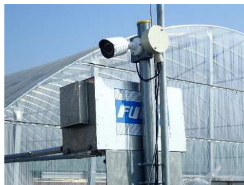
防犯カメラの設置
