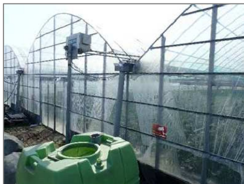
防犯カメラの設置
