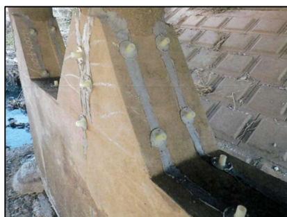
ひび割れ注入状況
