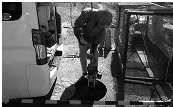
カメラを搭載したロボットによる下水道管腐食調査
