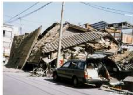
＜図1－7＞ 住宅被害の様子
