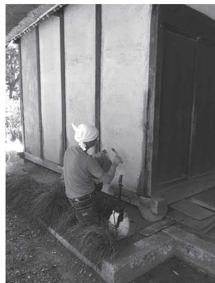
▲旧加藤家住宅 土壁修繕の様子
