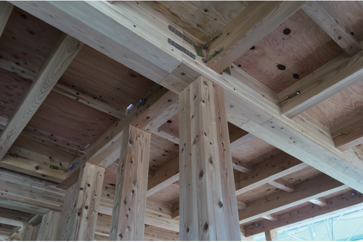
木造住宅用の金物を用いて接合された束ね柱と束ね梁の接合部分
