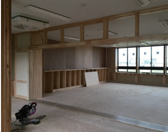
天井の不燃化による上階延焼防止
