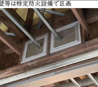
壁等部分の防火区画貫通処理
