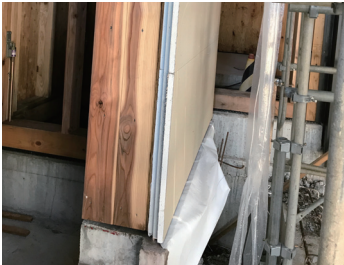
壁等部分の防火被覆施行中の様子
