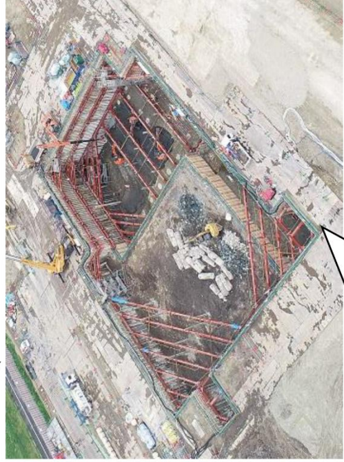
建物の基礎部分を掘削しているときの様子 (令和6年2月)
