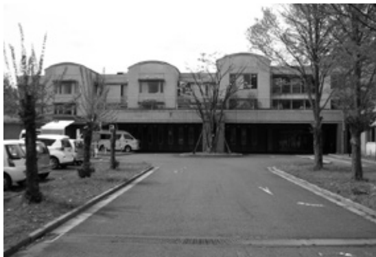
施設機器更新工事予定の六花
