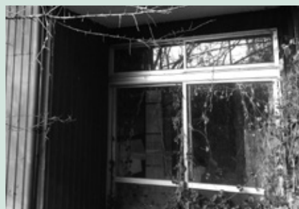
草木におおわれた空き家
