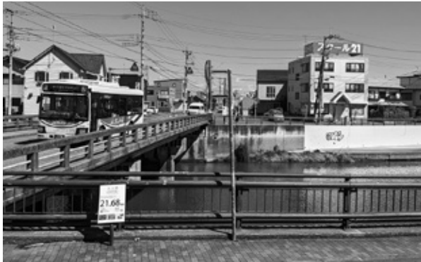
本年度は下流側に歩道となる側道橋を架ける
