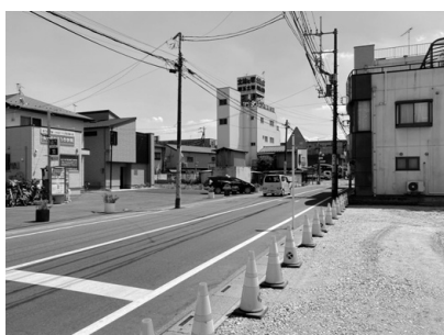
整備が進む東武動物公園駅東口
