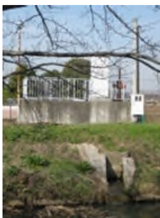
笠原排水機場
