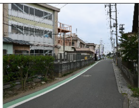
②小学校の北西側道路より
