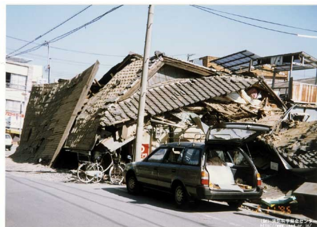
<図1-7> 住宅被害の様子
