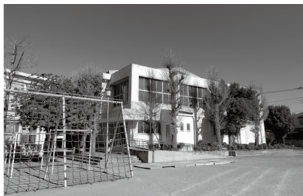
避難所の体育館は、早急なエアコン設置が必要不可欠
