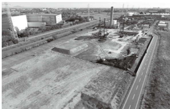
久喜市新ごみ処理施設、建設始まる (久喜市HP空撮)
