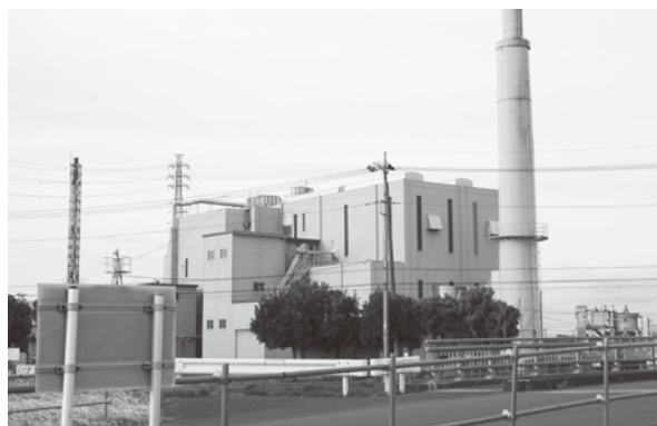
令和9年4月解体予定の現焼却施設 50年余の歴史
