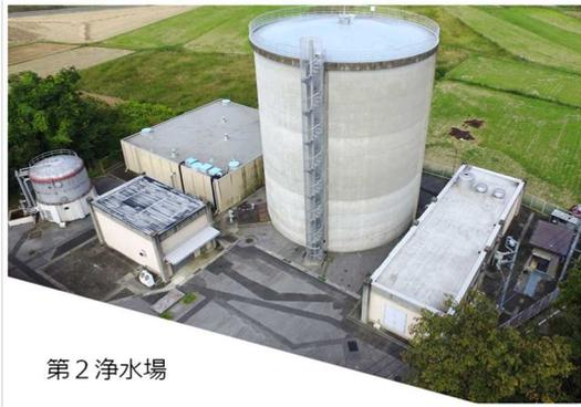
増加する水需要に対応して昭和47年1月に建設に着手し、昭和48年7月に工事を完了して給水を開始しました。現在、3箇所の水源（深井戸）から取水し、急速ろ過（除鉄・除マンガン）によって浄水処理した水と、埼玉県営水道からの浄水をあわせて給水しています。
