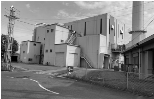
解体時期は令和9年度から令和11年度を予定
