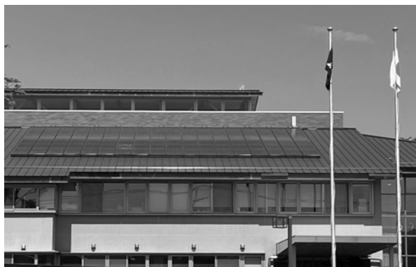
庁舎の屋根に設置されている太陽光パネル
