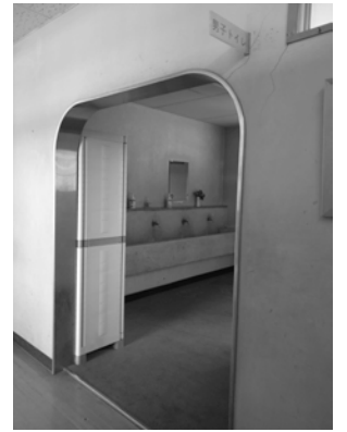
前原中の改修予定のトイレ
