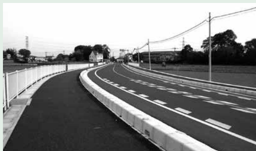
整備が進む町道12号線
