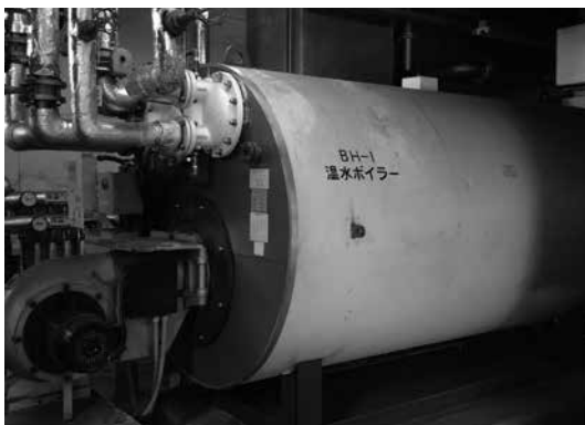
総合運動公園プールのボイラー更新
