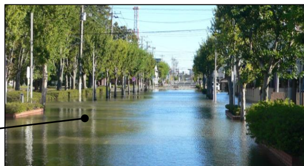
令和元年台風 19 号時道路冠水写真
