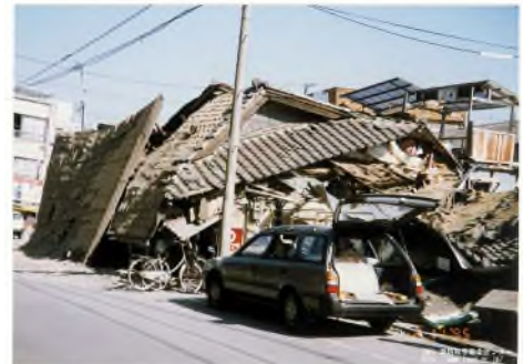
<図1-7> 住宅被害の様子
