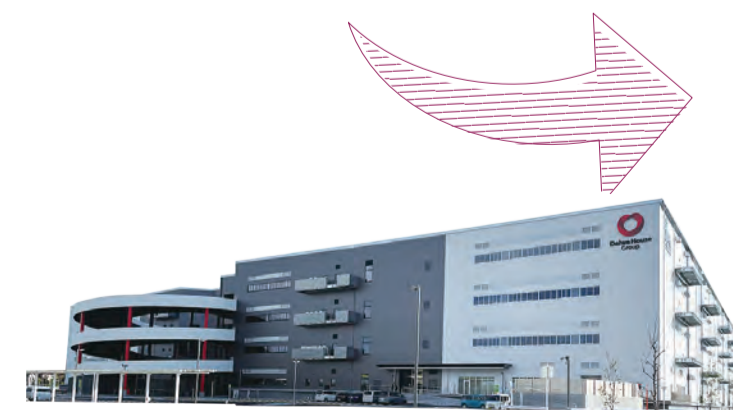
この建物は従来よりも50%エネルギーを削減する設計となっ ています。さらに、今後は建物上部に太陽光パネルを敷設し、 全体の50%のエネルギーをまかなう予定とのことです。
