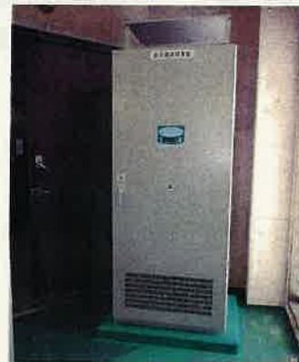
直流電源装置盤施工後
