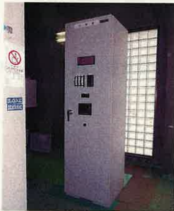
計装盤盤施工後
