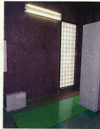
計装盤施工後(撤去後)
