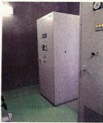
計装盤施工前
