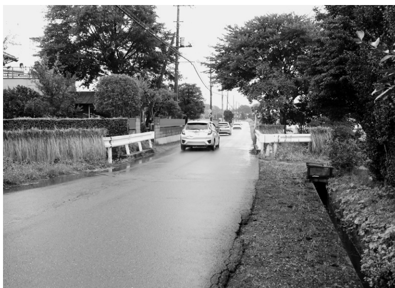
町道第 61 号線の改善と橋の拡幅を
