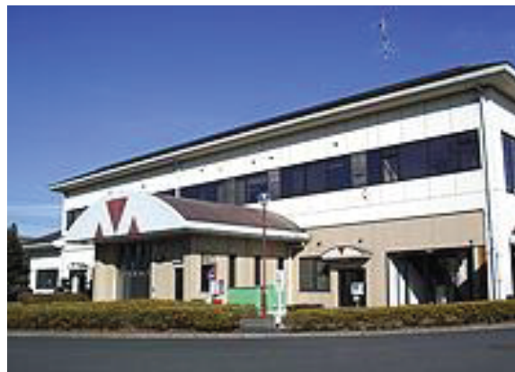
八甫清掃センターし尿処理施設
