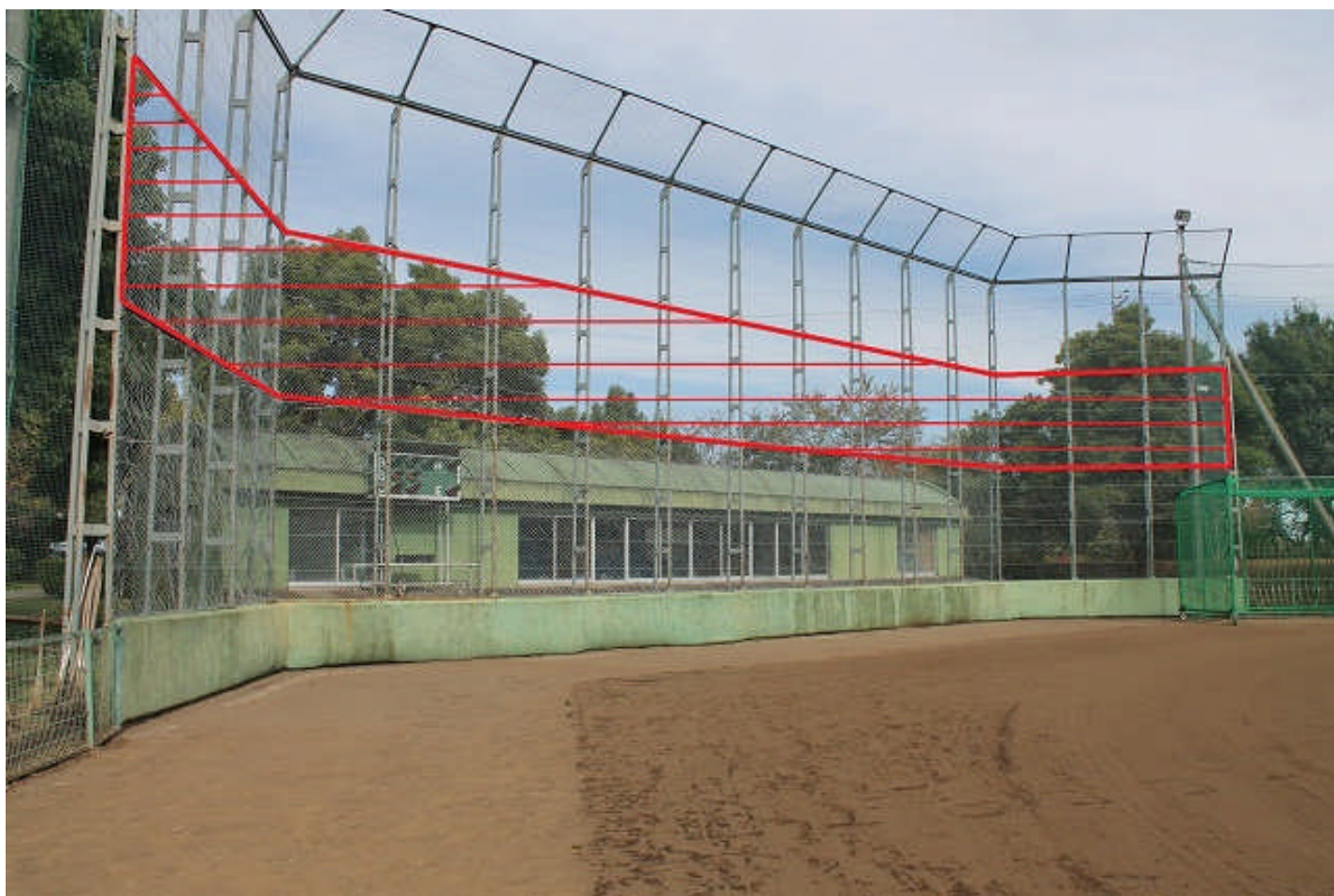
野球場放送棟とバックネット(中段部分:斜線の範囲を修繕予定)
