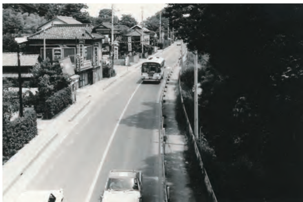
旧国道16号松伏周辺（昭和40年代）
