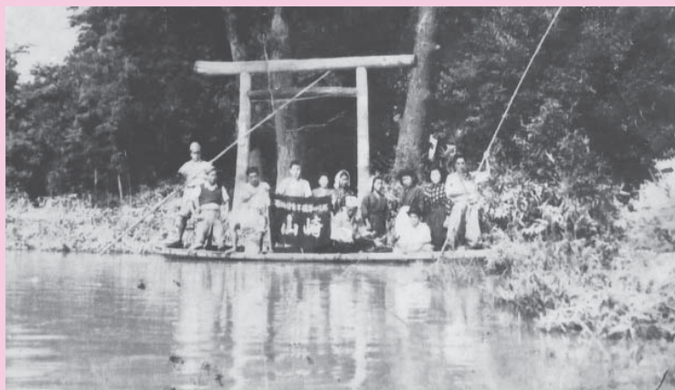
カスリーン台風時の赤松浅間社付近 昭和 22 年
