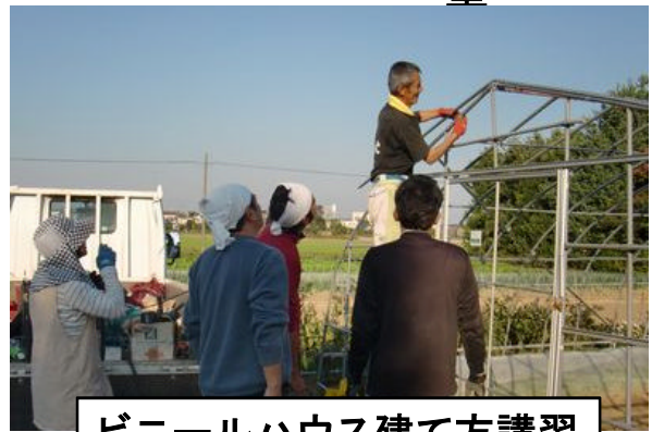
ビニールハウス建て方講習
