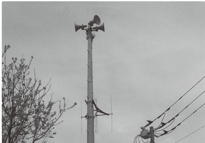
防災無線の対策もしっかり
