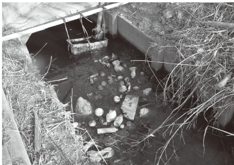
水の流れが悪いため、ゴミや土砂、ヘドロが堆積している
