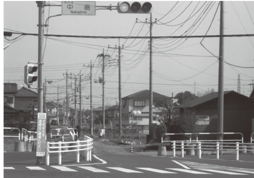
測量調査が実施される中島地区新橋通り線
