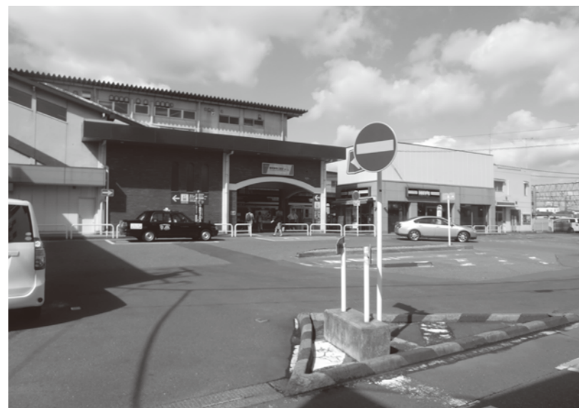
早期整備が望まれる東武動物公園駅東口
