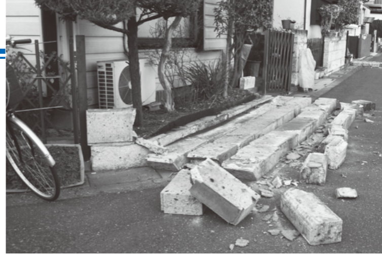
3・11の地震により倒壊した塀（町内）
