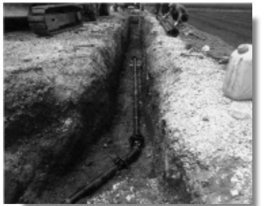
進む老朽管の交換
