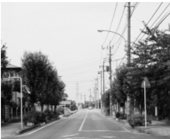
排除したい電柱
