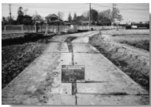
西条原地内の管路布設現場
