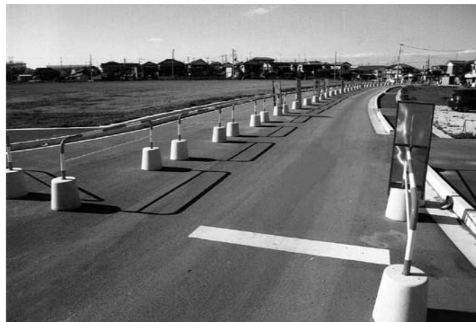
工事中の宮代通り線とスーパー出店予定地（左側） （道仏地区土地区画整理地内）
