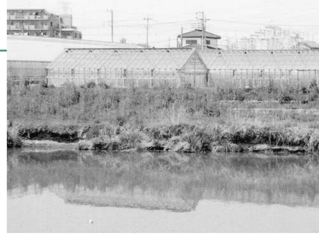
大落古利根川の土手崩壊進む
