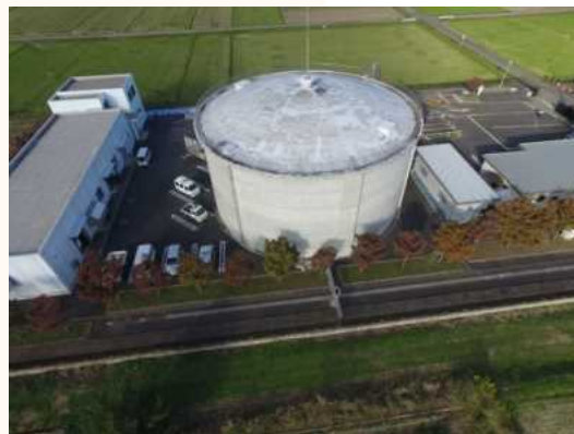
②宮東配水場 (平成4年築造)
