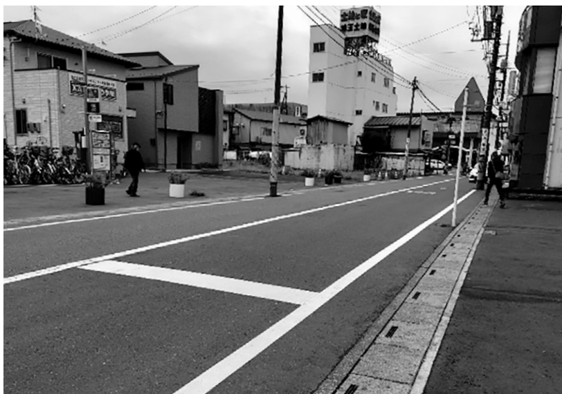
順調に進む東武動物公園駅東口駅前整備
