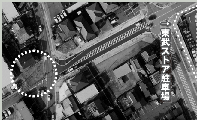
東武動物公園駅西口、進む歩道整備
