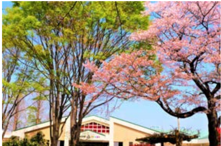
110. 完成間近の福祉交流館
