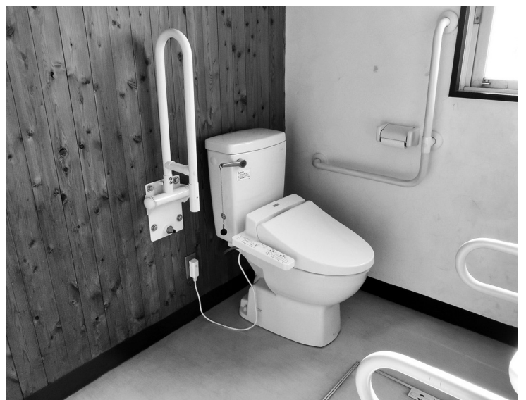
洋式化された体育館のトイレ（百間小学校）。災害時も安心
