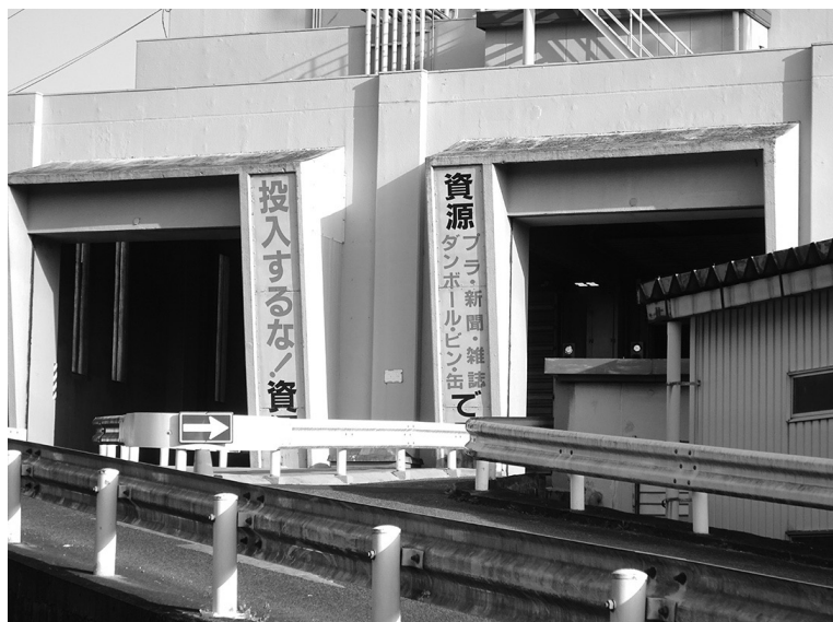
久喜宮代清掃センター1・2号焼却炉ピット入口
