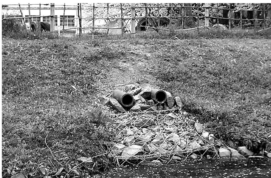
校庭の下を通水して笠原沼落川へ排出するパイプ出口
