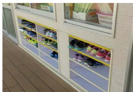
ジュニア棟に設置された靴箱
