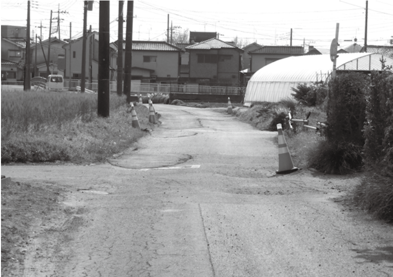
早急な修繕が求められている危険な状態の町道17号線（宮東地内）
