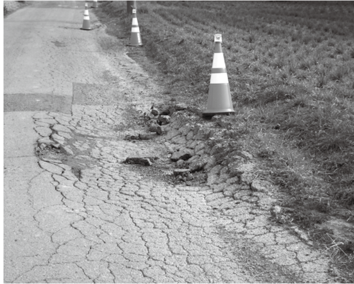
至る所に わだち 轍があり危険な状態の町道17号線
