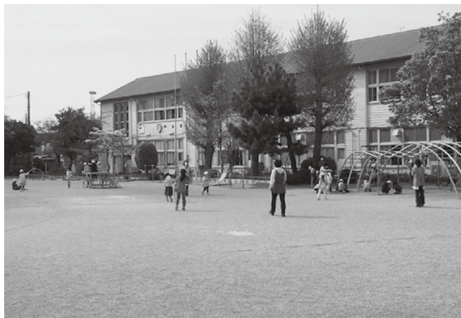
県内でも珍しい木造校舎の東小学校
