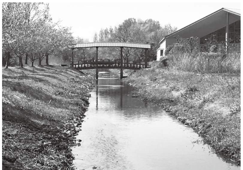
笠原沼落川。マコモの除去と川底整備が完了（4月10日）
