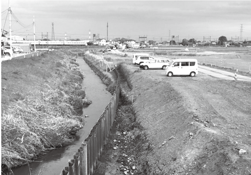
急ピッチで整備が進む「姫宮落川」の河川改修（3月7日）
