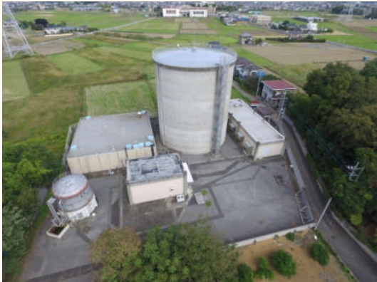
①第2浄水場 (昭和47年築造)
