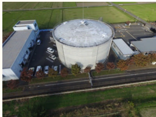
②宮東配水場 (平成4年築造)
