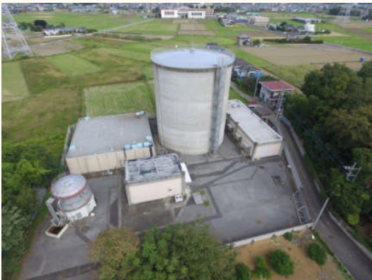
①第2浄水場 (昭和47年築造)
