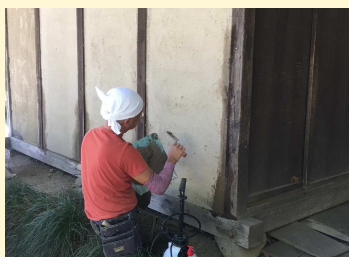
旧加藤家住宅の土壁修繕の実施
