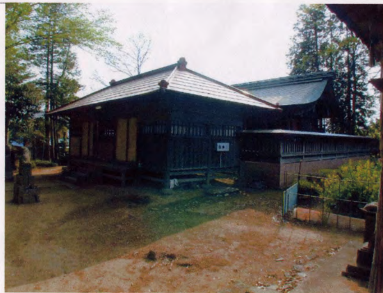
拝殿(手前)及び本殿(奥)正側面(北東より)
