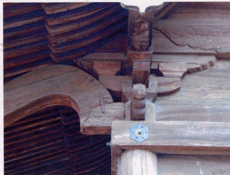
向拝海老虹梁の破損(鏝による応急処置)
