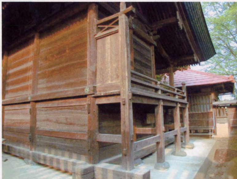
側面縁廻(南西より)
