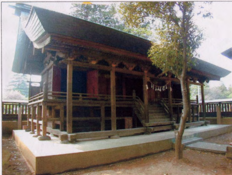
正側面(南東より)
