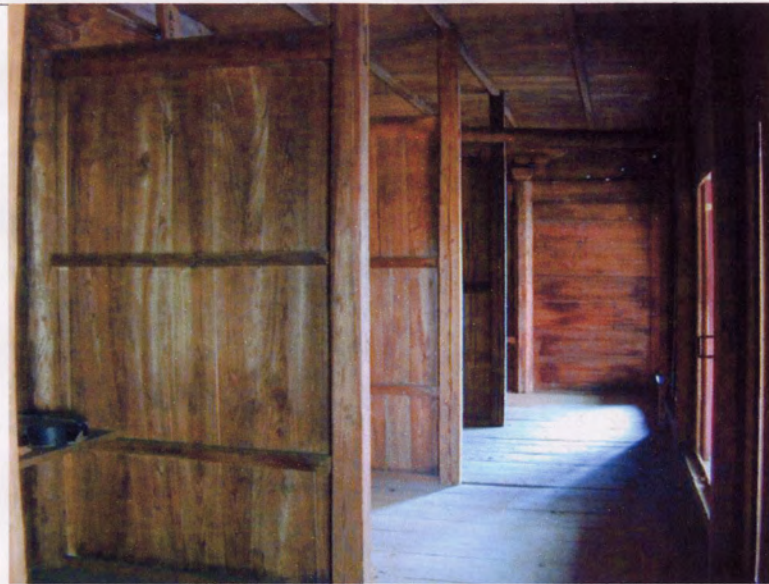
内部(五社が間仕切で仕切られている:南より)
