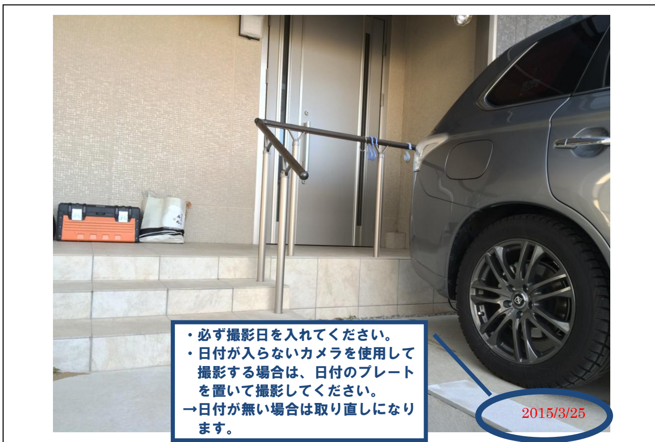
①玄関外手摺 (施行後)
