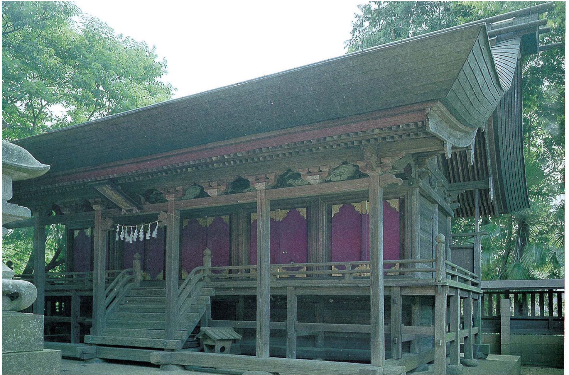
五社神社本殿(宮代町最古の建造物 安土桃山時代)
