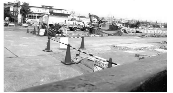
建屋撤去工事が進んでいる旧杉戸工場跡地
