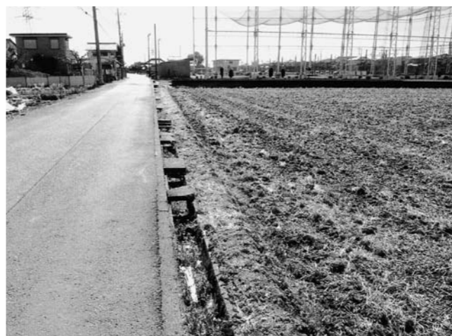
側溝整備で安全に
