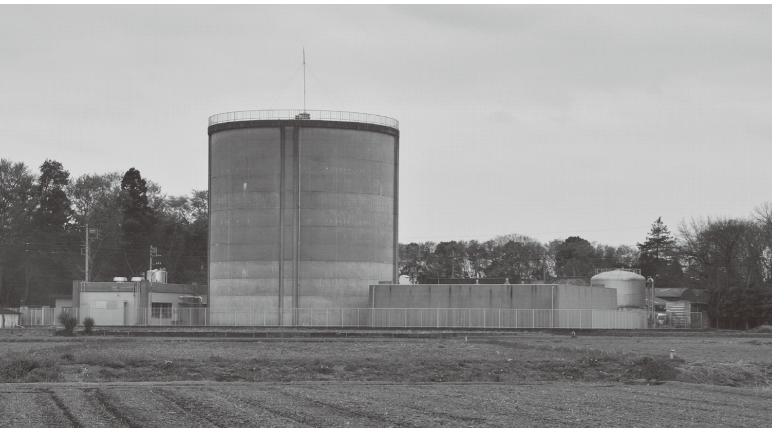
水道はライフラインの基本（西条原の第2浄水場全景）
