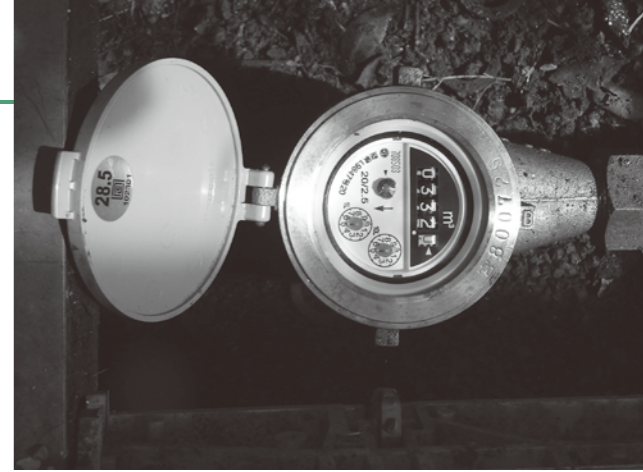
水道メーターが一気に上がります
