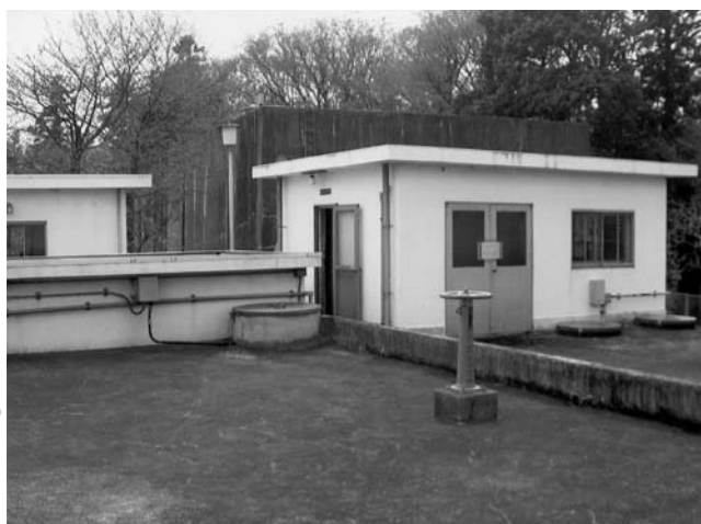
改修工が必要な第一浄水場
