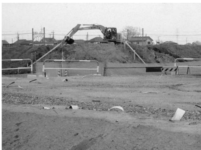
道仏土地区画整理事業の工事完了は
