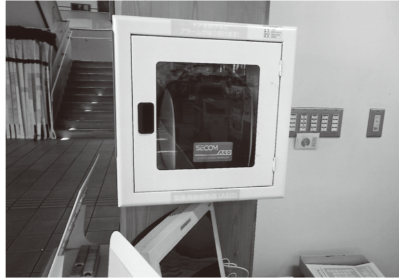
戸籍住民窓口近くに設置されているAED
