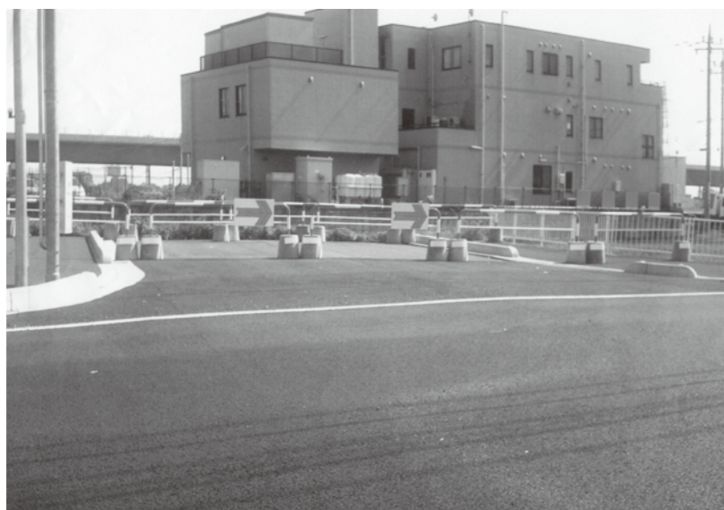
進まない県道春日部久喜線（和戸地内）
