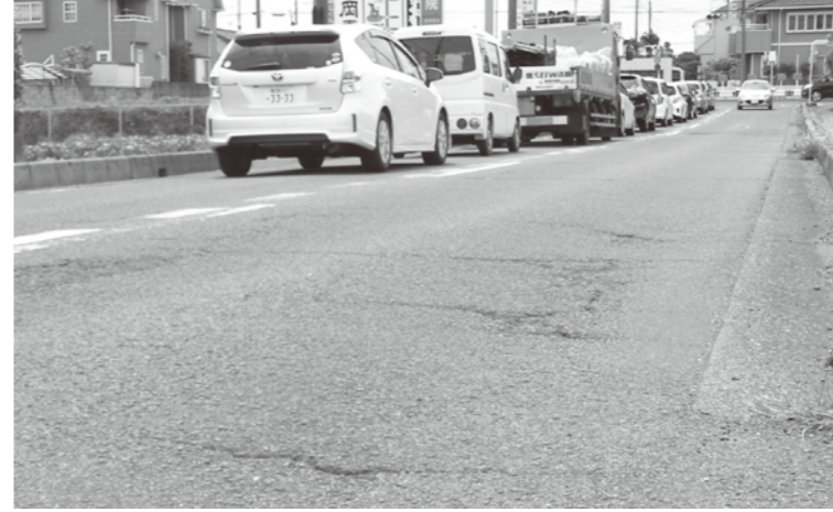
舗装修繕される町道75号線（万願寺橋通り）
